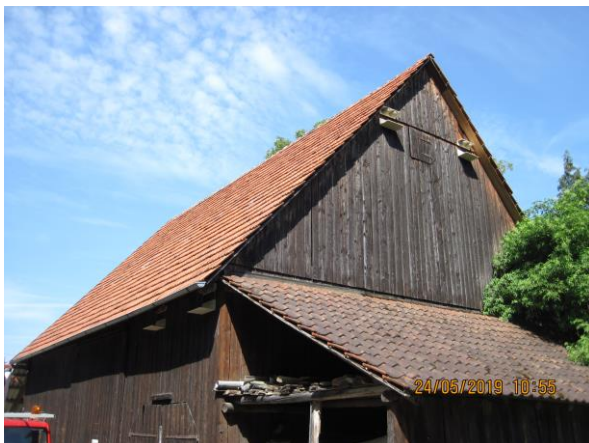
Abb. 4: Ausgleich für die Mehlschwalben-Doppelnester an Wohnhaus 10
